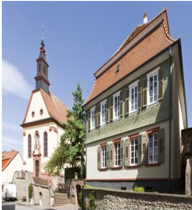
Pfarrhaus und Kirche nach der Renovierung
