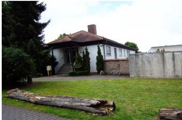
Schwesternhaus vor der Renovierung
